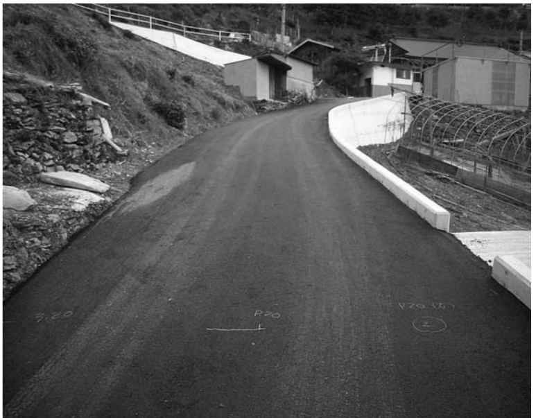
町道赤根線完成
