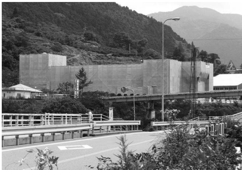
耐震補強工事が始まった大豊町中学校校舎
