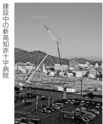
建設中の新高知赤十字病院
