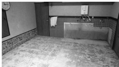
修繕中の地区集会所
