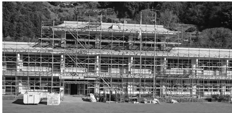
工事中の旧大田口小学校
