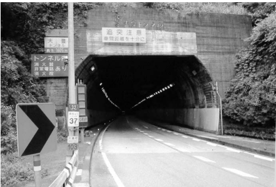
吊り天井式撤去計画の大豊トンネル
