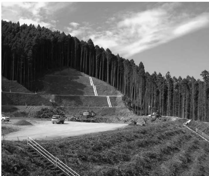
川口南地区造成工事
