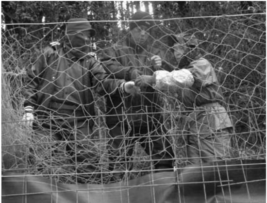
防護ネット張り（怒田地内）
