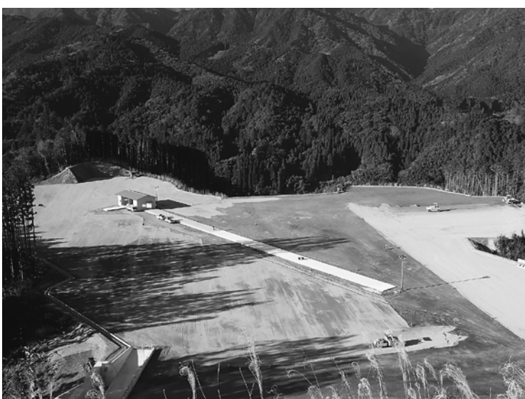
完成間近のストックヤード
