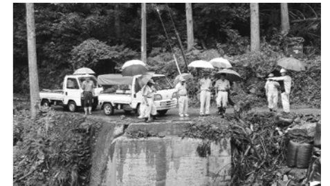
立川災害復旧状況調査
