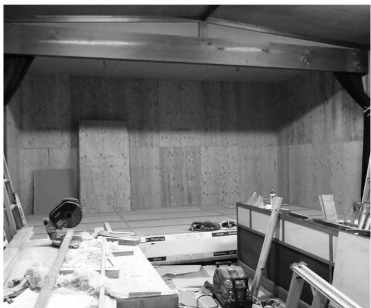
集会所の耐震工事中
