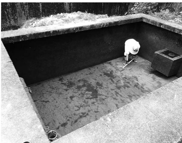
濾過池清掃作業
