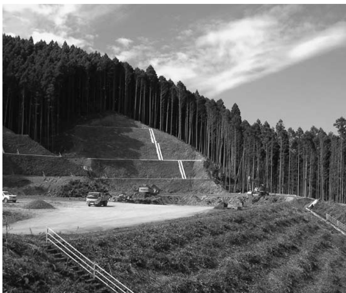
川口南地区造成工事
