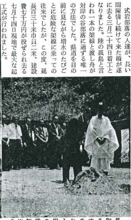
式岩架橋の架入れをする町長
