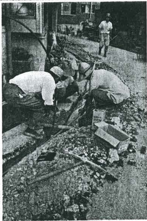
各家庭へ待望のパイプも引かれた (旧国道筋)
