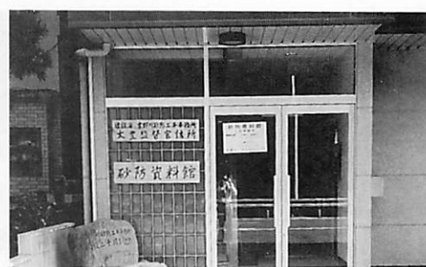
完成した砂防資料館入口
