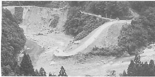
町内は、至る所で崩壊、栗生の仮設道(439号)も流失する
