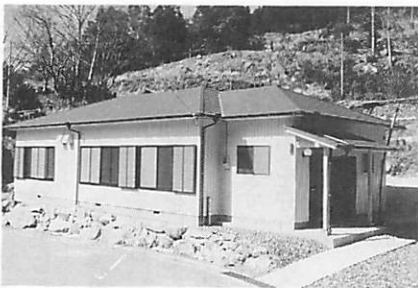
完成した久寿軒集会所。
