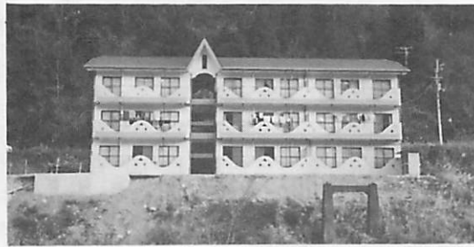
中村大王に完成した「大豊町ふるさと住宅」
