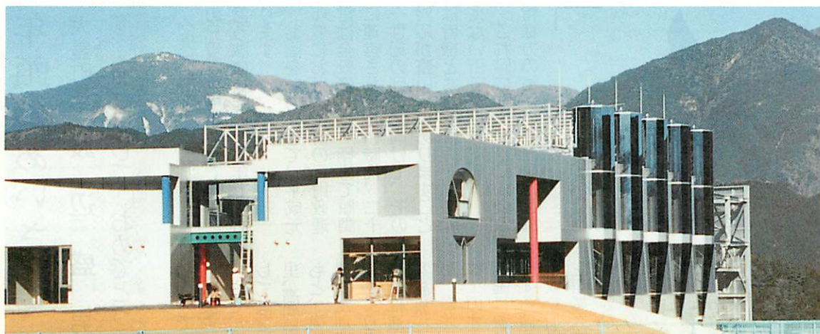
完成間近の嶺北21世紀休暇センター全景
