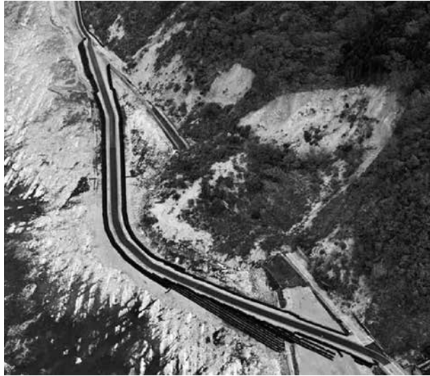
海底隆起箇所を通る仮設迂回路
