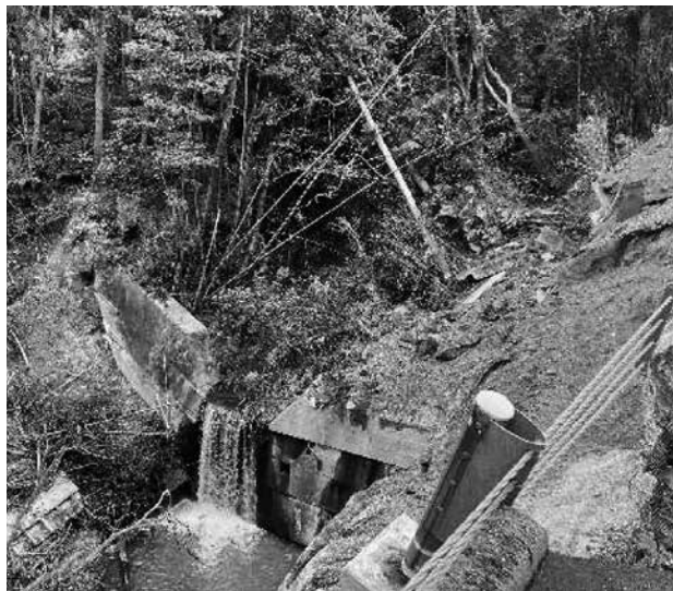
地すべりエリア 斜面崩壊
