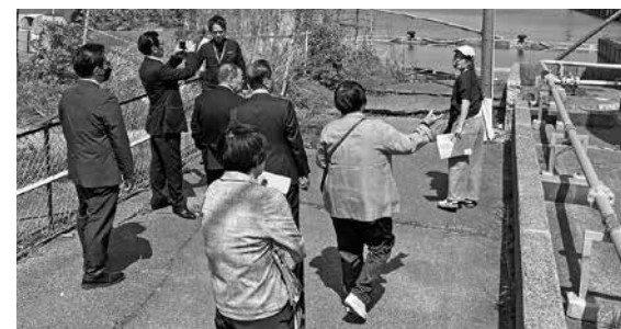
災害復旧工事 視察
