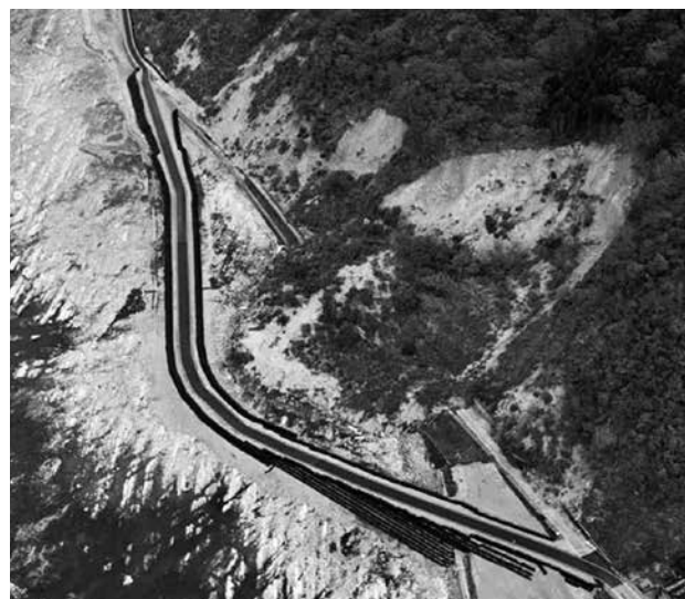
海底隆起箇所を通る仮設迂回路
