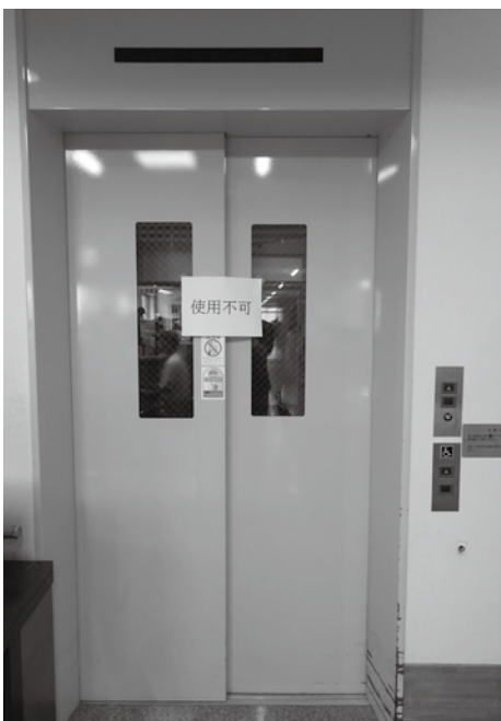
旧老人ホーム時代に設置されていたエレベーター
