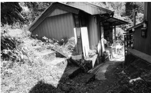
赤道の補修が必要な場所
