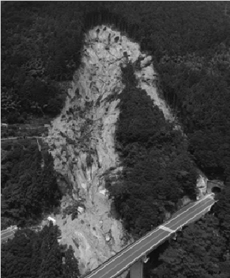
大豊町で発生した山腹崩壊 (平成30年 7月撮影)
