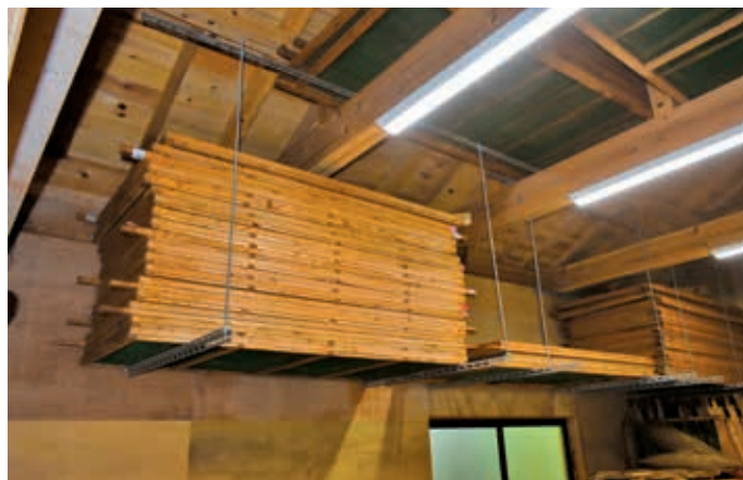
写真 5-6 北窪家の作業場（令和4年（2022）6月14日） 寝かし時にムロになる土間。上部に吊り棚を作り、機能的に道具を収納。エアコンも設置されている。
