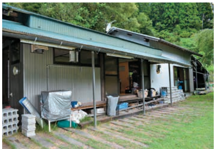
写真5-5 北窪家の作業場（令和4年（2022）8月5日）
