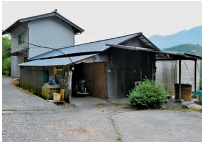
写真5-3 小笠原家の作業場（令和4年（2022）6月5日） 茶刈りの日。切妻側の覆い屋の下に蒸し桶、建物の裏手の下屋に生葉用のエンジン式小型運搬車が見える。
