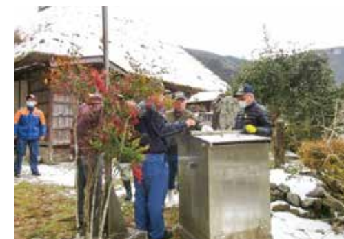
昨年の旧立川番所書院の消火設備 (自動放水銃等)の点検の様子
