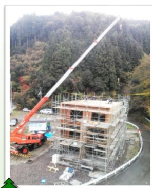
県産材普及啓発(CLTI工法) 高知おおとよ製材社宅建設費を補助 (H25年度)
