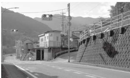
町道杉線起点側
