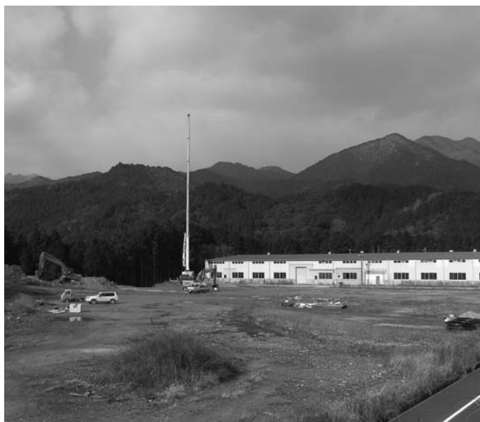
高知おおとよ製材工場建設地
