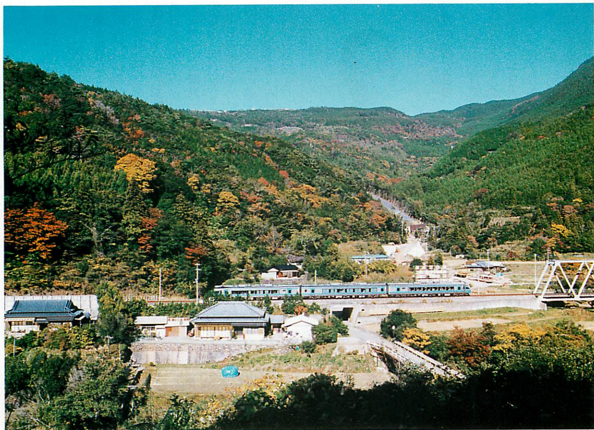
大豊町集落シリーズ「大王上部落」(梶ヶ森スカイライン工事入口付近)
